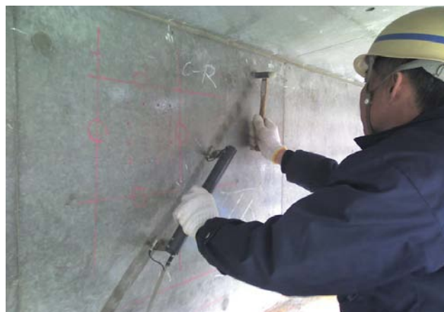
写真-4 振動検出器による橋梁の圧縮強度測定状況
